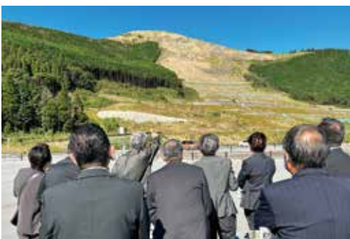
阿蘇斜面防災工事のようす
