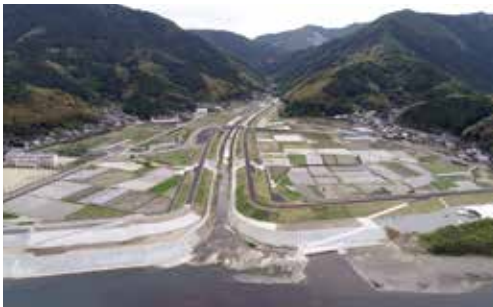
加茂堤防の完成 (那賀川床上浸水対策特別緊急事業:国土交通省)
