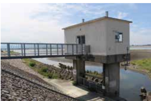
耐震化のため新設予定の辰巳那賀川樋門
