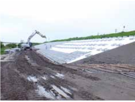
那賀川の堤防漏水対策工事のようす（上中町中原）
