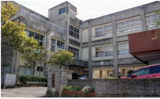
老朽化している羽ノ浦小学校
