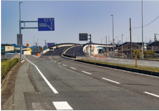
那賀川大橋4車線化（令和2年3月14日開通）
