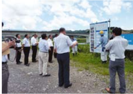
東九州道北川橋建設地
