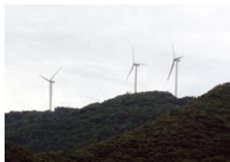
佐田岬半島の風力発電所
