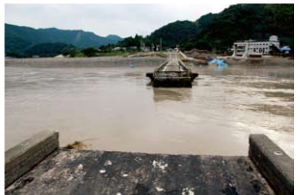
台風12号で一部が流失した中央橋（加茂谷）
