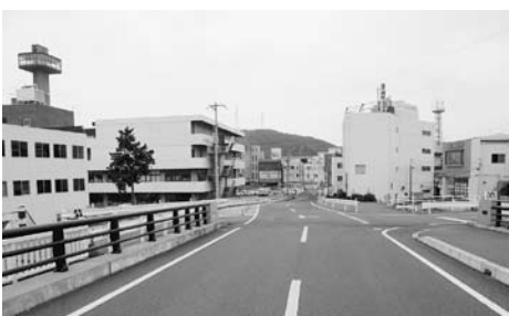
新庁舎建設にあわせた道路整備が求められる(市道富岡横見線)
