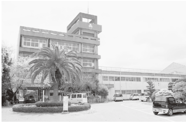
解体後、新管理棟の建設が予定されている(阿南第一中学校)
