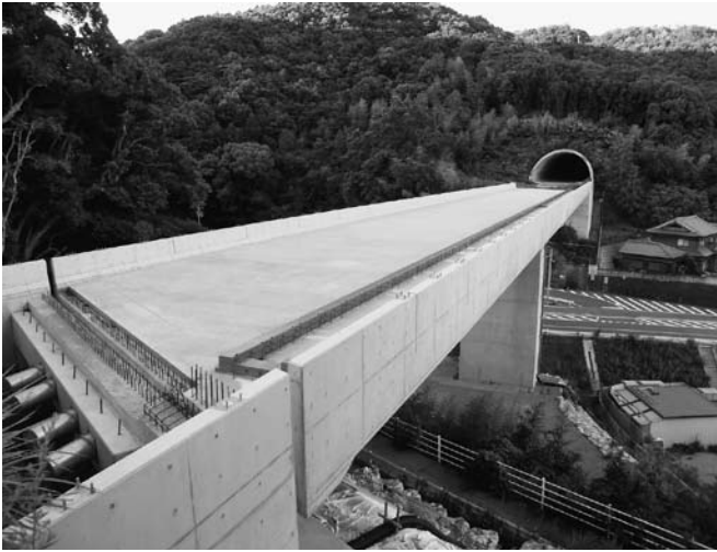
橋ランプの高架橋
