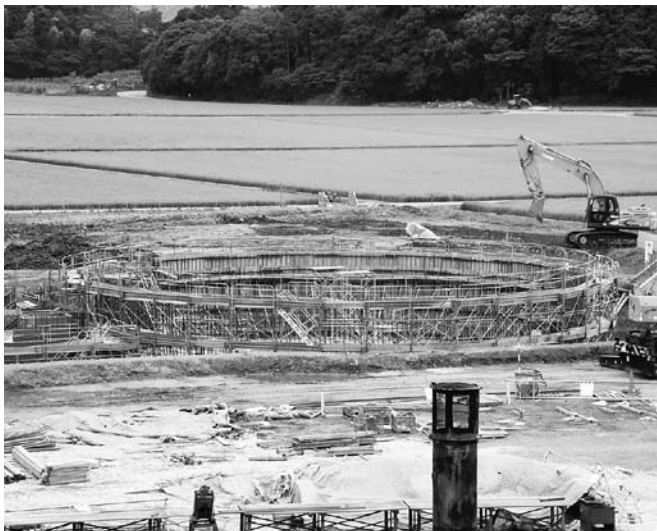
富岡浄化センター沈殿池工のようす
