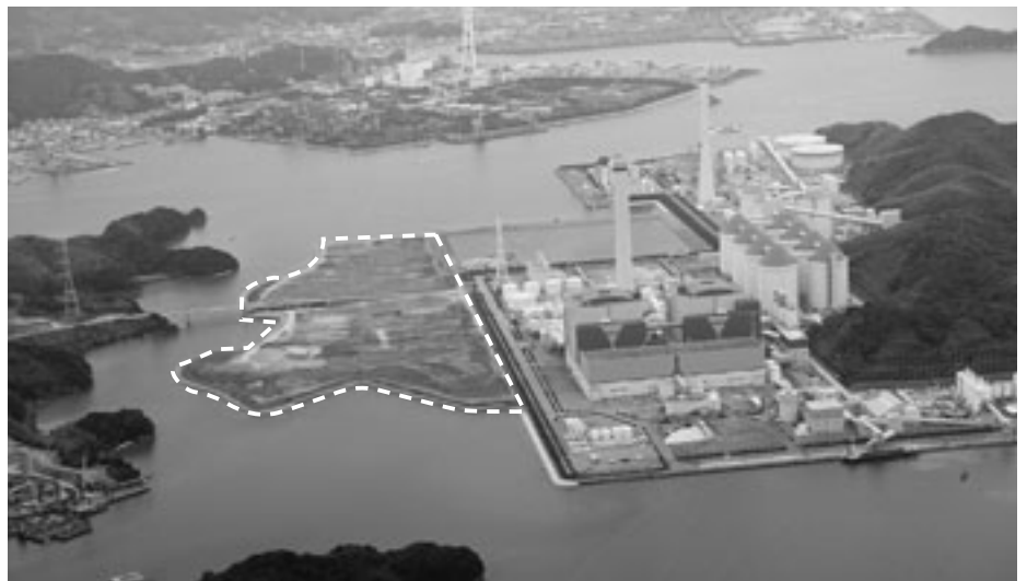
整備スケジュールが遅れている橋港公共用地(中央部)
