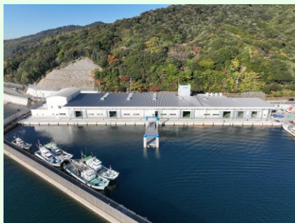
徳島県立椿泊漁港荷さばき所
