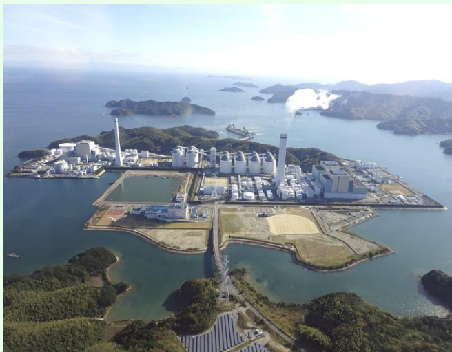
橘湾石炭火力発電所
