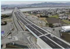
一般国道55号阿南道路4車線化(令和2年)
