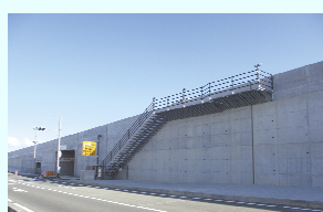
那賀川町 中島緊急避難階段
