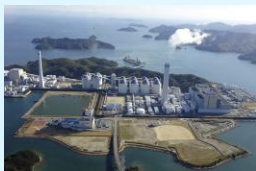
橘湾石炭火力発電所全機運転開始(平成12年)
