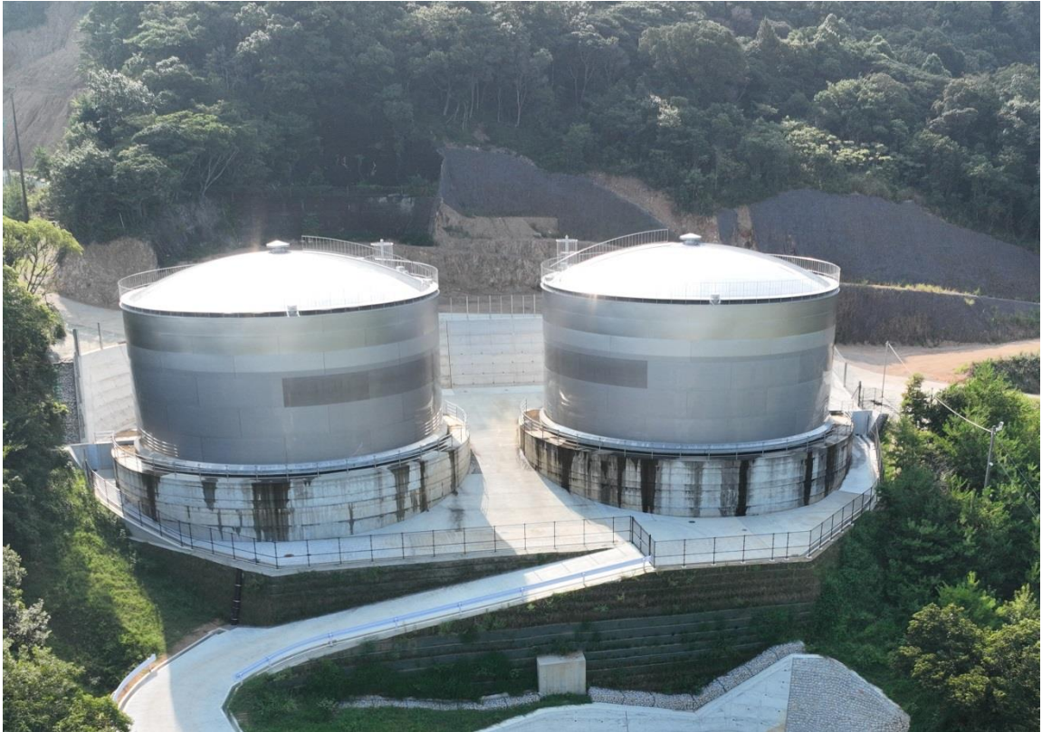
阿南市上水道 富岡配水池
