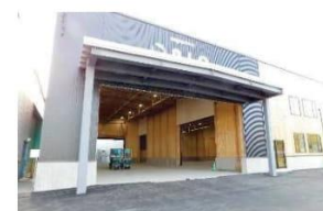
大盤パネルを用い大空間を実現した取組例 ニヘイ札幌配送センター（石狩市）
