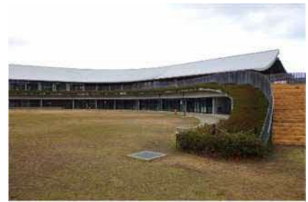
広場側から見た施設
