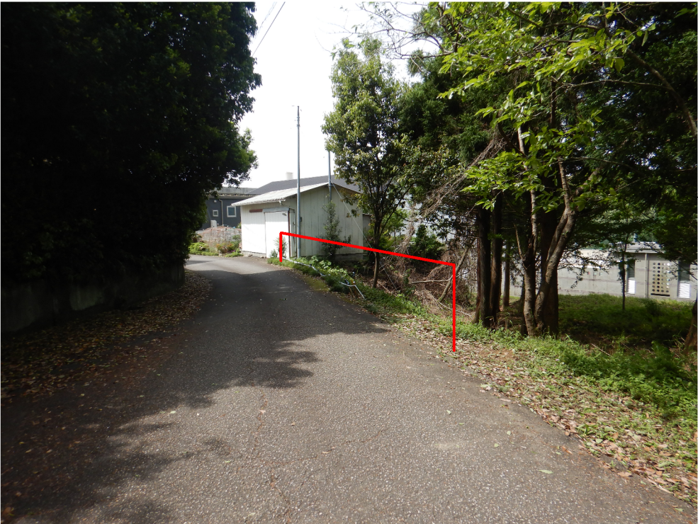
工事箇所写真
