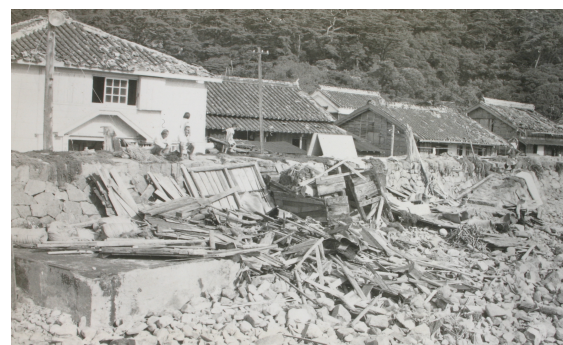
高潮による被害状況（伊島町）
