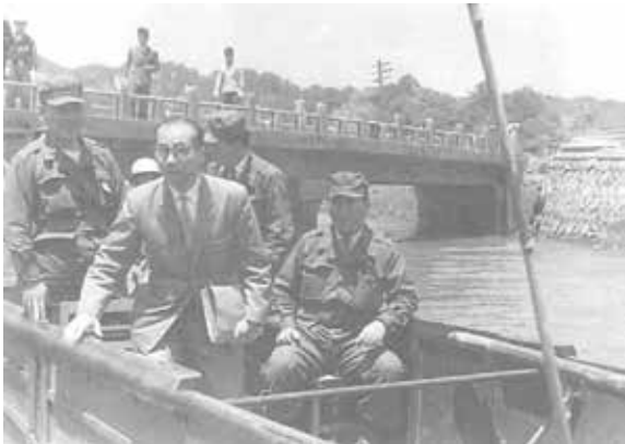
桑野川改修工事での現地視察
