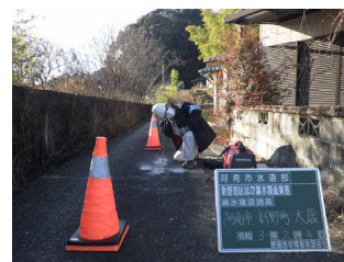
漏水調査状況(確認調査)
