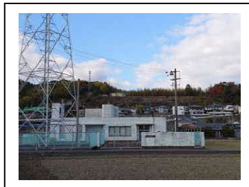
③⑤ 羽ノ浦上水道センター
