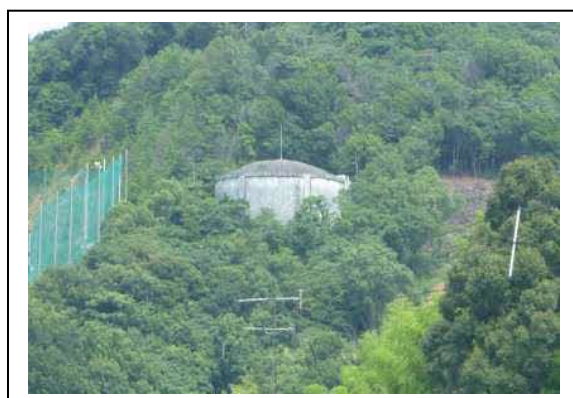
④ 富岡配水池
