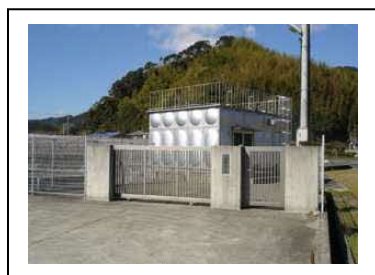
②① 久田ポンプ場
