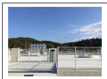
㊸ 福井水源地 (平成30年10月 供用開始)
