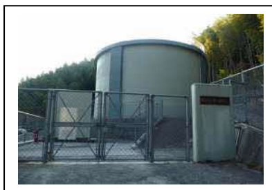
①⑦ 川西配水池
