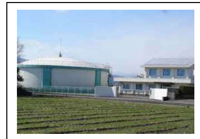
③① 西原水源地
