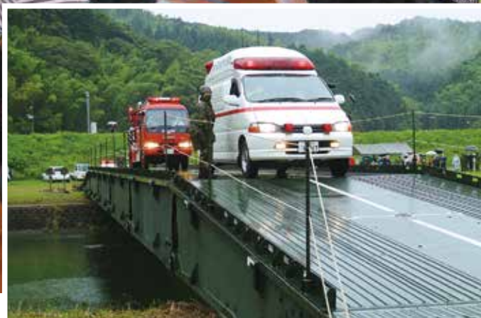
災害に備えた自衛隊との橋梁架設訓練
