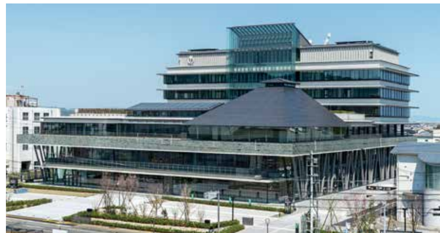
災害時に司令拠点となる市役所
