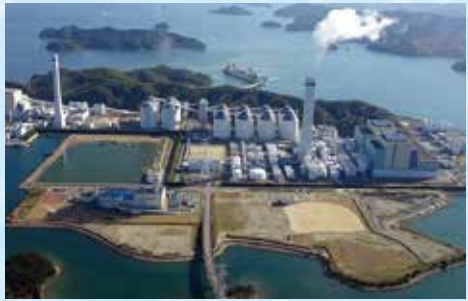
橘湾石炭火力発電所全機運転開始(平成12年)
