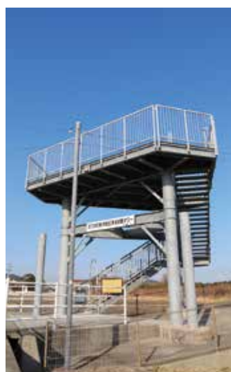
津乃峰町新浜地区津波避難タワー
