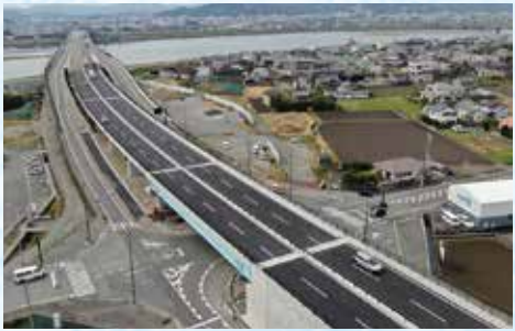
一般国道55号阿南道路4車線化(令和2年)
