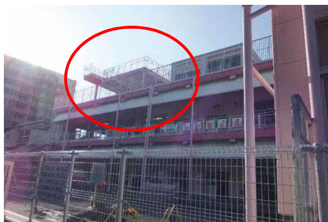
図 15 屋上への避難場所を増築した事例
