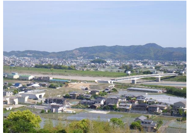
工事が進む[四国横断自動車道(阿南 IC 付近)]
