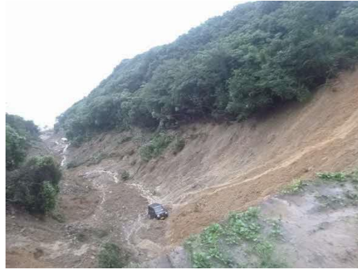
斜面崩壊の状況 樺町那波江 (平成 26 年 8 月)
