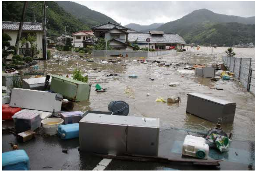
平成 26 年台風 12 号による洪水被害 県道阿南小松島線 加茂町不け (平成 26 年 8 月)
