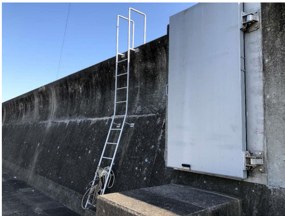
本市管理の海岸保全施設
