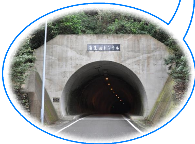
四国最東端 蒲生田トンネル
