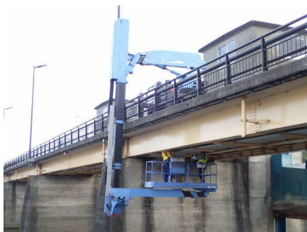
新町橋（橋梁点検車による点検）
