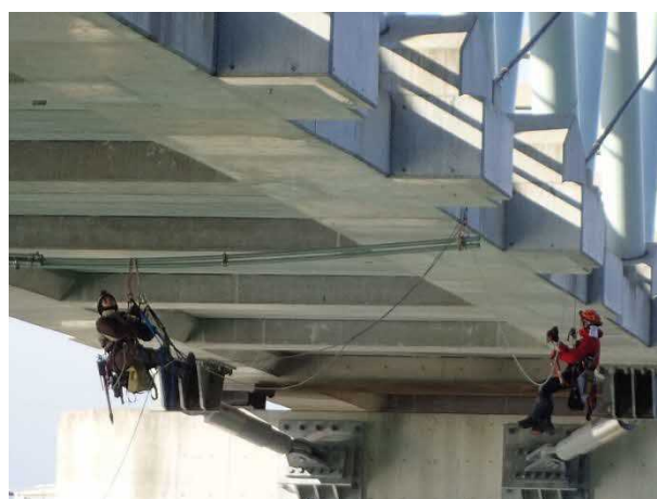
会下橋（特殊高所技術による点検）
