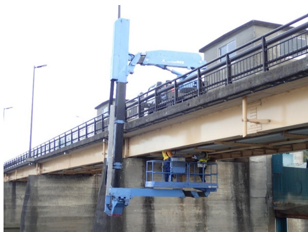
新町橋（橋梁点検車による点検）
