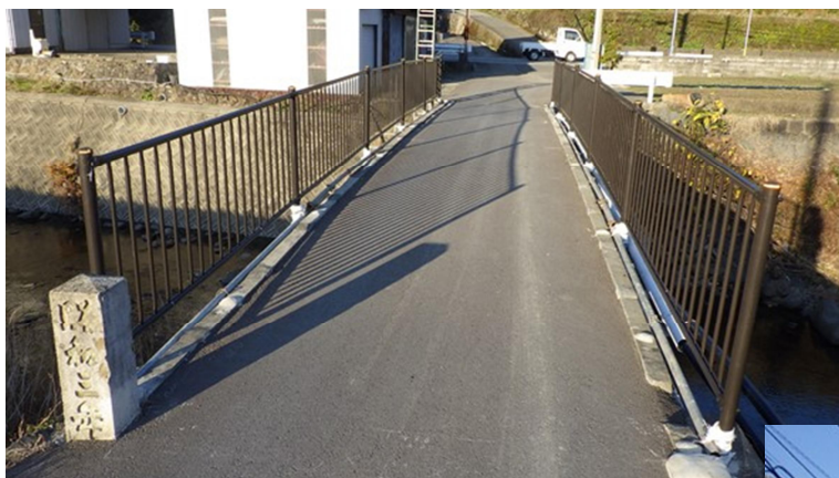
昭和3年にコンクリートで 造られた橋
