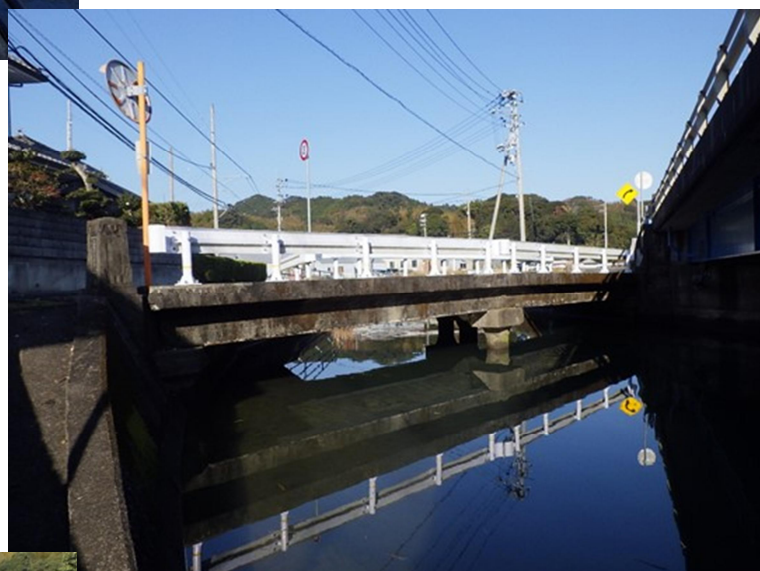
昭和15年にコンクリートで 造られた橋
