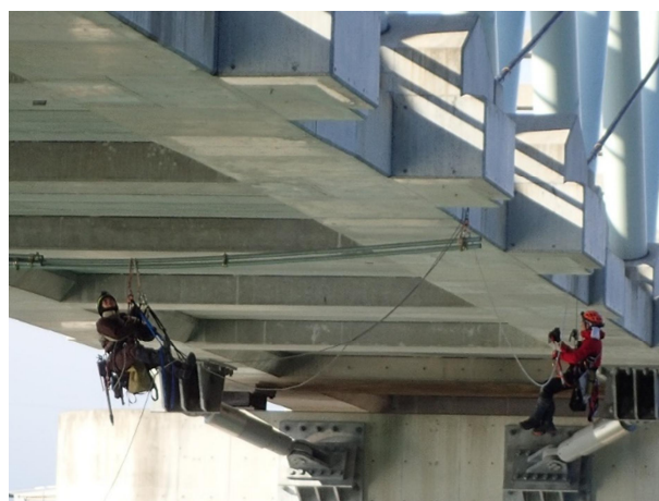
会下橋（特殊高所技術による点検）
