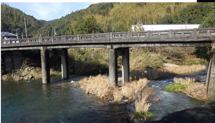
昭和25年にコンクリートで 造られた橋
