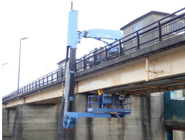
新町橋（橋梁点検車による点検）
