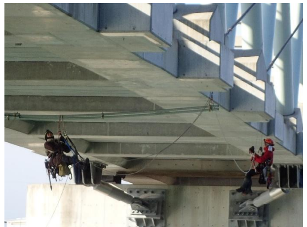
会下橋（特殊高所技術による点検）
