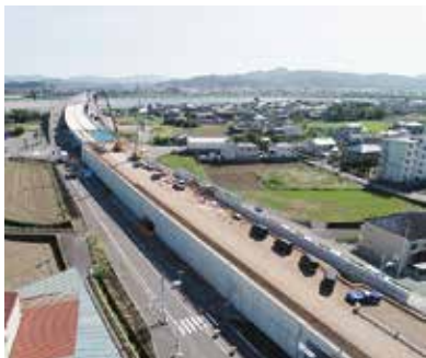
▲4車線化工事が進む国道55号那賀川大橋
