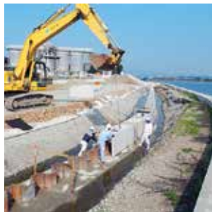
▲那賀川・桑野川河口部の堤防のかさ上げ工事
