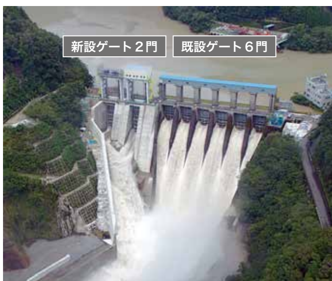
《8月16日新設ゲート稼働状況（約550m 3 /秒）》
