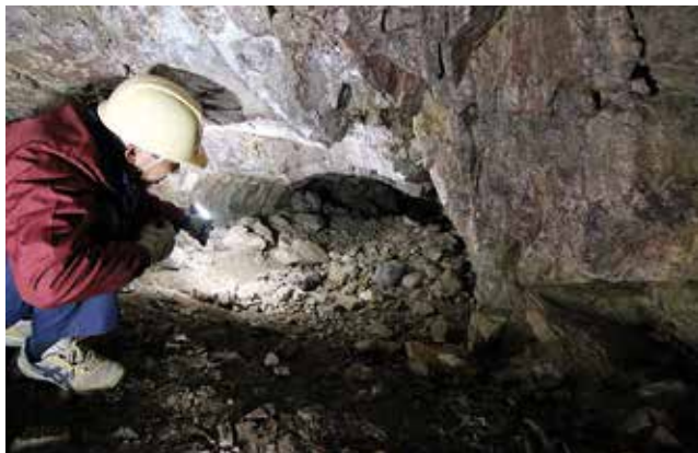
採掘坑跡 坑内内部
