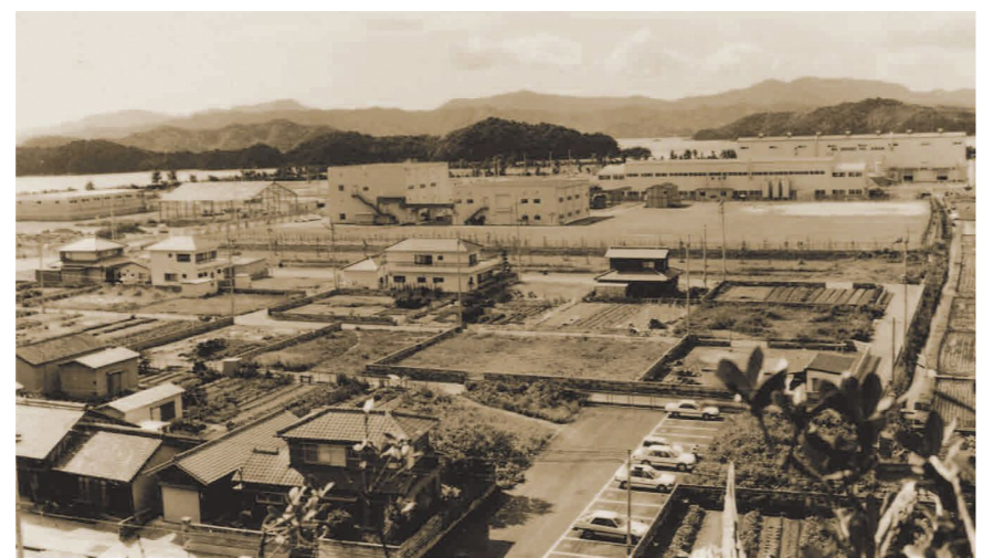
▲大湯・新浜工業用地に進出した阿南化成(株)（平成元年）
