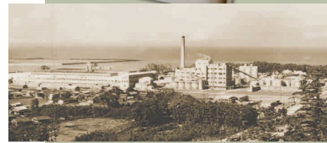
▲昭和34年8月に操業を開始した神崎製紙(株)富岡工場
