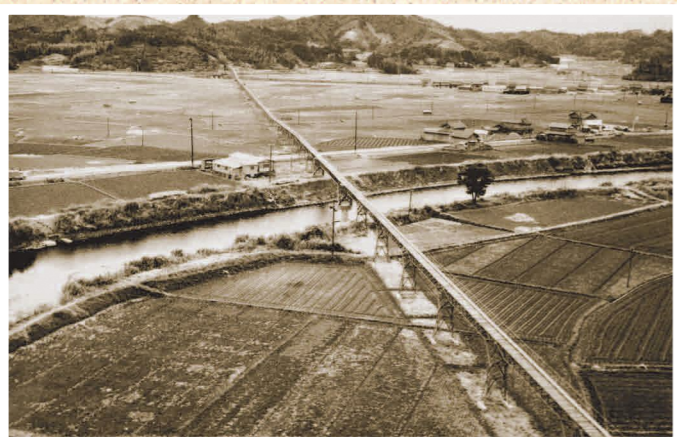
▲ 鉱石を運ぶベルトコンベア 桑野町を横断する広浦鉱業(株)のベルトコンベア。熊谷町の鉱山で採掘された鉱石(石灰石)を積出港の橘町幸田に輸送するため、昭和39年11月に建設された。
