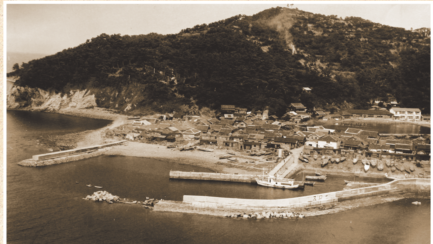
▲ 伊島の町並み 港周辺に形成された集落。港内には漁船が陸揚げされ、初代連絡船「美島丸」が着岸している。平成13年には、港内に設置されたものとしては全国初となる「可動式防波水門」が完成し、台風などの暴風雨の際に、漁船と島民の安全を守っている。(撮影/昭和36年頃・提供/川西藤彦さん)
