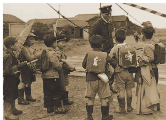
▲踏切番 踏切には、列車が通過する時に遮断機を下ろしたりして安全を守る「踏切番」と呼ばれる駅員が立っていた。警報機が普及した現代では見られない懐かしい光景である。（撮影/昭和32年・提供/タカツ写真館）
