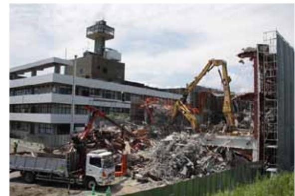
分庁舎を解体する様子。（8月18日現在）
