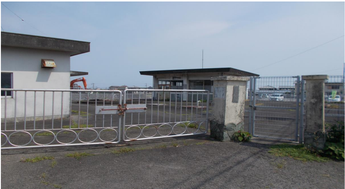
羽ノ浦第1水源地
