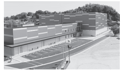
羽ノ浦スポーツセンター
