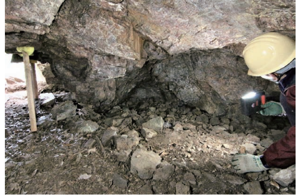
写 17. 坑内より東側開口部をみる
