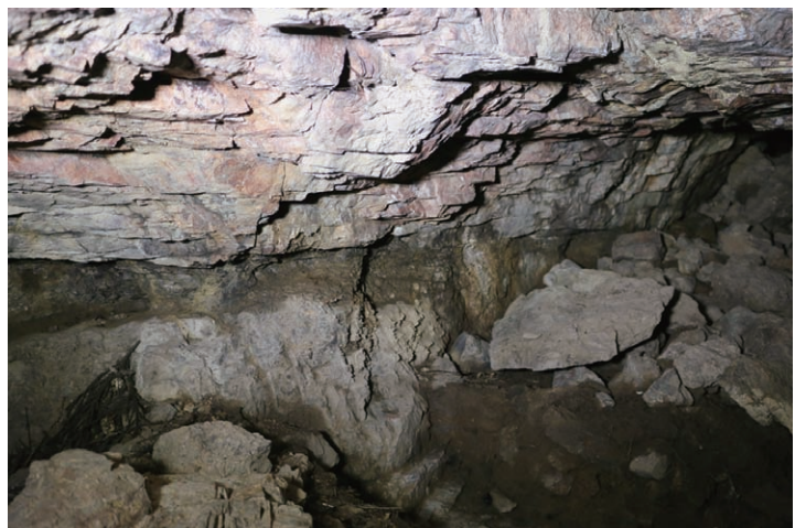
写 4. 坑内南側壁面の段々形状と東西方向に走る石英脈
