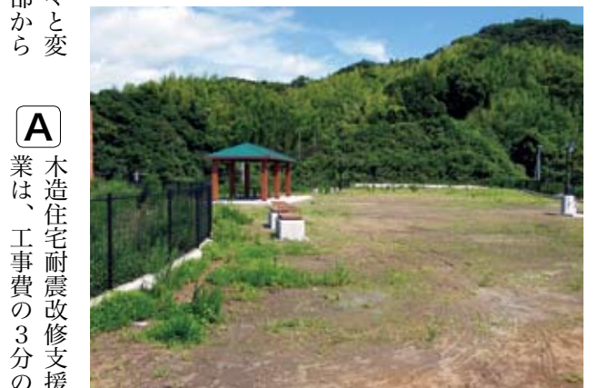
整備が進む橘地区防災公園
