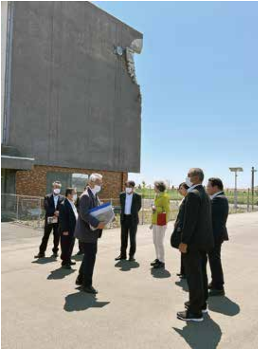
気仙沼市向洋高校旧校舎 (気仙沼市東日本大震災遺構・伝承館)
