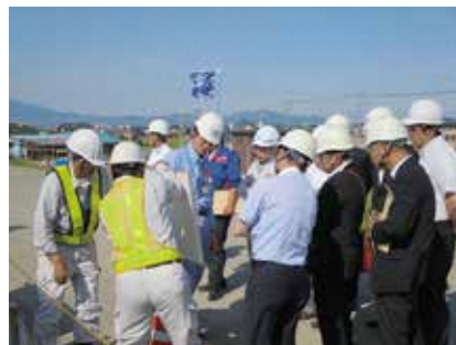
堤防復旧工事現地説明のようす
