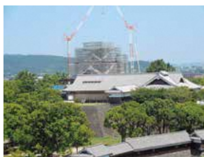
復旧工事が進む熊本城(熊本市役所14階から)
