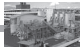
富岡雨水ポンプ場 自然流下やポンプで排除されます。
