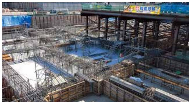
建物の基礎となる部分のようすです。鉄筋組立が完了し、型枠を組んでいます。このあと免震装置の据付を行います。
