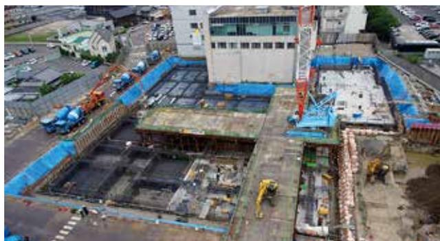
新棟の建物面積が広いので、中央部分には工事車両の乗り入れ台を構築しています。120トンのクローラークレーンも乗り入れ可能で、資材や重機を必要な場所に移動させることもできます。
