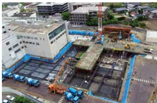
建物を支える基礎となる部分にコンクリートを流し込みます。コンクリートは1日約200m<sup>3</sup>(コンクリートミキサー車約50台分)
