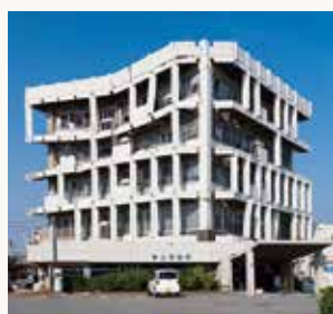
被災した宇土市役所庁舎 (写真提供：宇土市)
