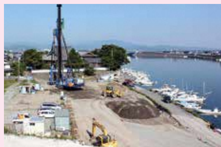
堤防地盤の液状化対策
