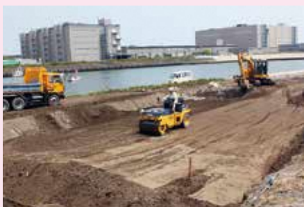
堤防の嵩上げ
