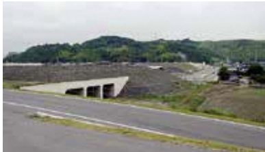
羽ノ浦町岩脇付近工事の様子
