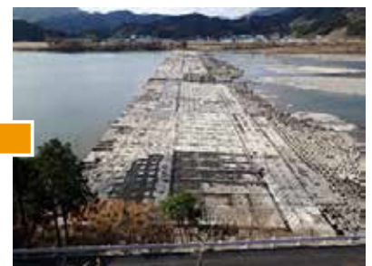
南岸堰改修前
