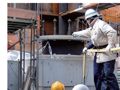
地下1階柱頭部分に設置された免震装置
