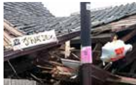
倒壊した家屋
