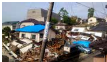
倒壊した家屋
