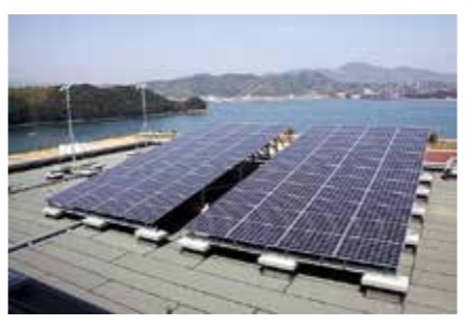
太陽光発電と風力発電装置
