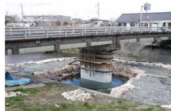
高度経済成長期に集中整備された橋の寿命を延ばすため、市では、橋長15メートル以上の重要な橋について「長寿命化修繕計画」を策定し、年次計画的に修繕工事を行うことにしています。工事は、市が管理する74橋のうち、10橋を先行して行う予定で、現在、岩戸橋(新野町)などで橋桁の補修や伸縮装置の取替、高欄補修などを施工しています。また、文化橋(柳島町)をはじめとする13橋において耐震化工事を進めています。
