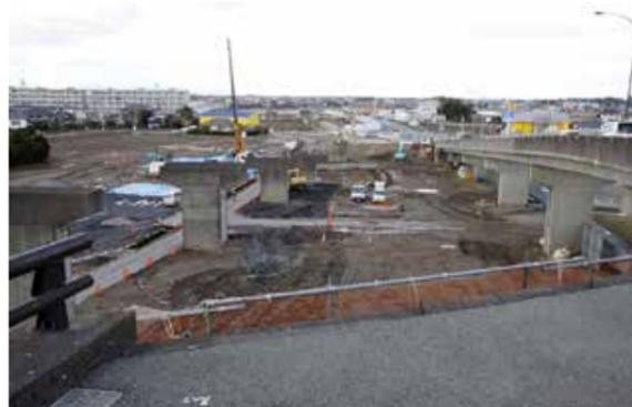
一般国道阿南道路で、国土交通省四国地方整備局徳島河川国道事務所による那賀川大橋付近の4車線化工事が始まりました。工事区間は、那賀川町中島交差点付近から西路見町江川交差点付近までの約2.1kmで、現在は、中島交差点付近の高架橋を整備するための道路改良工事などが行われています。
